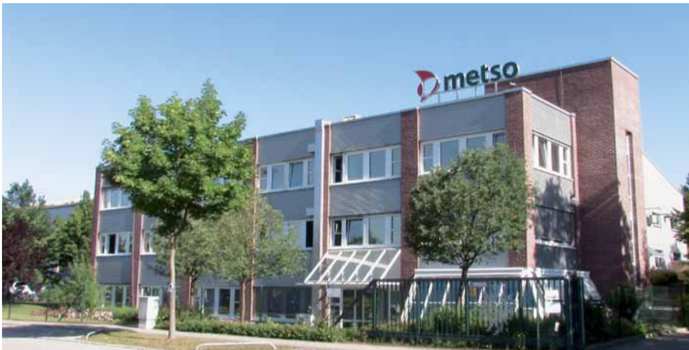
Metsos Automation Business hat mit dem rund 5.000 qm großen Werk in Horgau bei Augsburg eine eigene Produktionsstätte in Deutschland. Hier beschäftigt das Unternehmen mehr als 100 Mitarbeiter.
