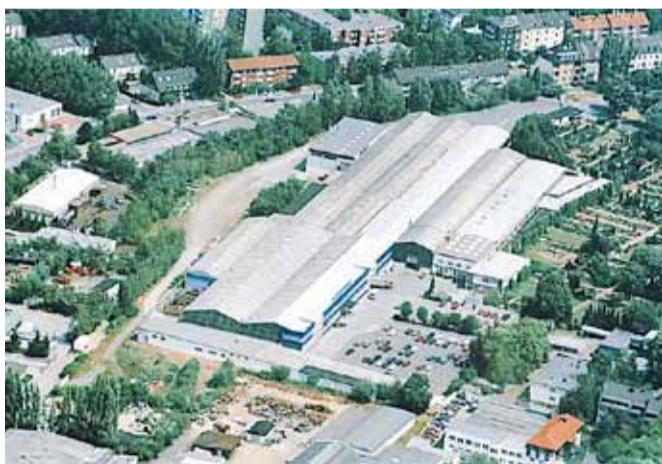
Das Bild erlaubt einen Blick auf das gesamte Gelände des Bochumer Werkes der Klaus Union.
