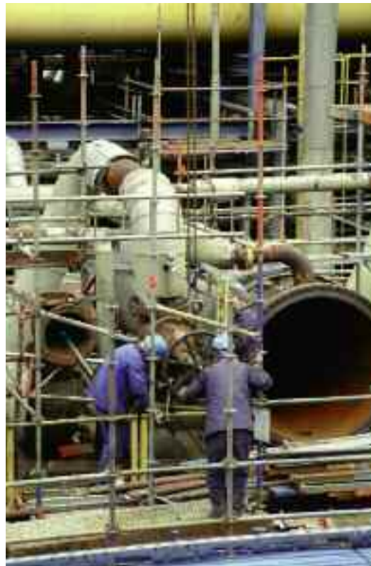
Vorbereitung zur maschinellen Wiederbearbeitung der Flanch-Fläche
