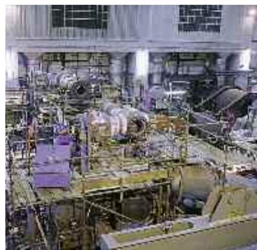
Reparatur einer Turbinen-Armatur in einem italienischem Kraftwerk
