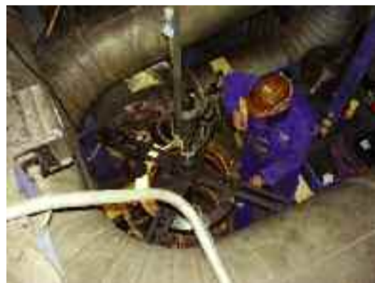
Schleifen der Turbinen-Armaturen
