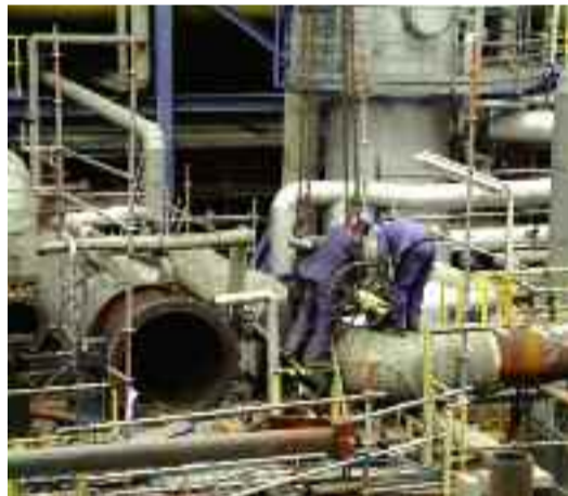
Remontage von Absperrschiebern
