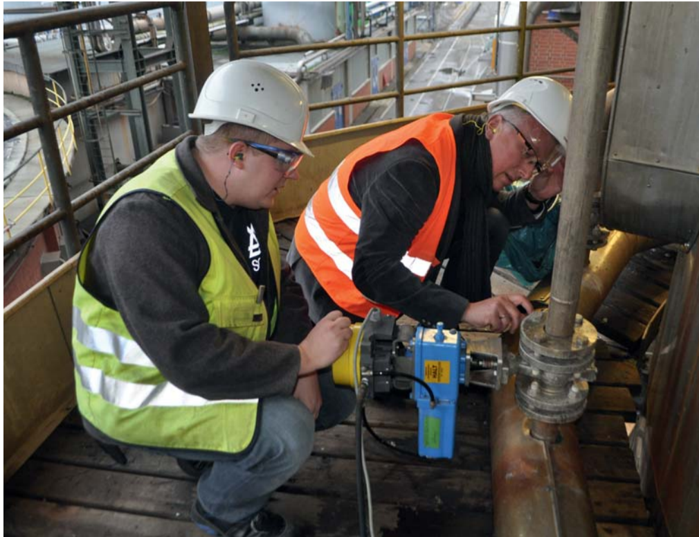
Jan Wattendrup (links), Leiter Instandhaltung für Elektro-, Mess- und Regeltechnik in der Zellstofflinie B des SCA-Werks in Mannheim, begutachtet zusammen mit Frank Hasenbach-Bauer (Sales Manager Geschäftsbereich Flow Control, Metso Deutschland) eines der am Kocher installierten V-Port-Segmentventile von Metso. (Foto: Metso)
