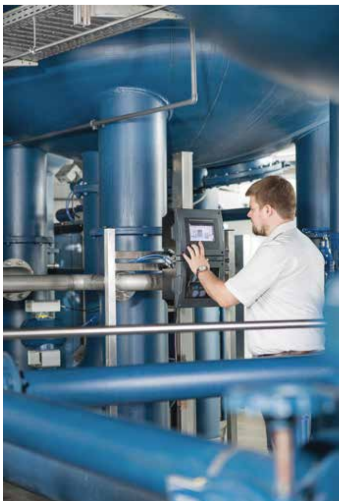
Die einfache Bedienung und Visualisierung des Online Analyse Systems Typ 8905 wird durch ein 7-Zoll-Touch-Display realisiert
