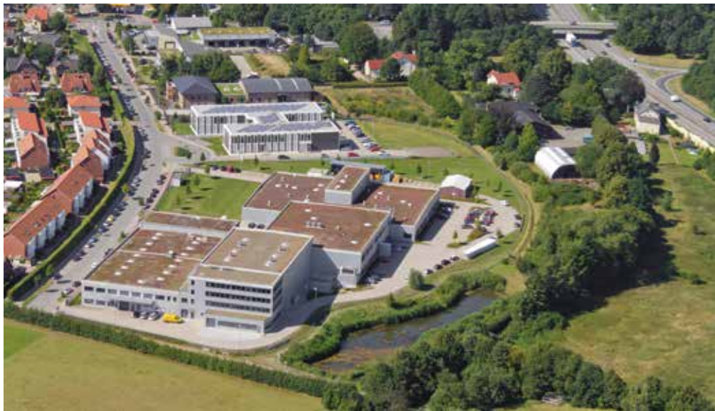
Firmengebäude am Standort Pinneberg: Im August wurde nach knapp einjähriger Bauzeit ein neues Lagergebäude mit integrierten Büroflächen in Betrieb genommen
